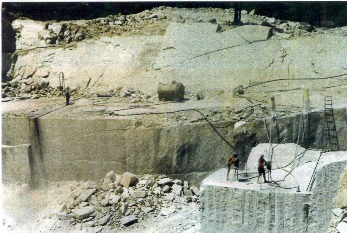
Foto 4. Corte de bloques con perforación y lanza térmica
